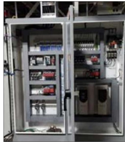
y salidas del PLC, se etiquetó el cableado y se agregaron los relevadores de seguridad y los variadores para ambos motores del
